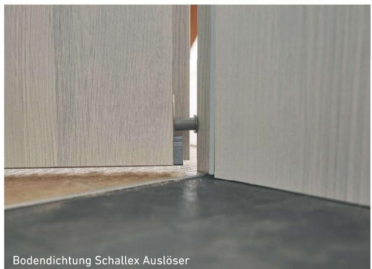
Bodendichtung Schallex Auslöser
